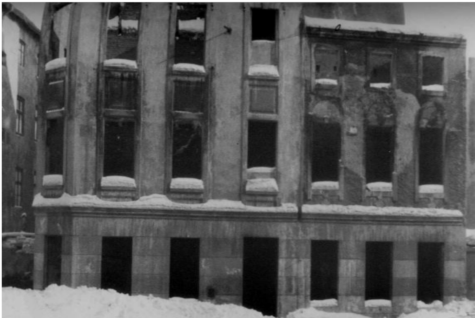
Spalony budynek szkoły „Ahawas Tora” na posesji synagogi przy ul. Wolborskiej – zdjęcie z zimy 1939/140
